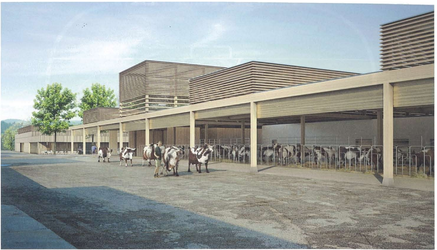
Der Milchviehstall wird aus vier offenen Stallungen gebildet. Alle drei Neubauten sind konsequent in Holz materialisiert.
