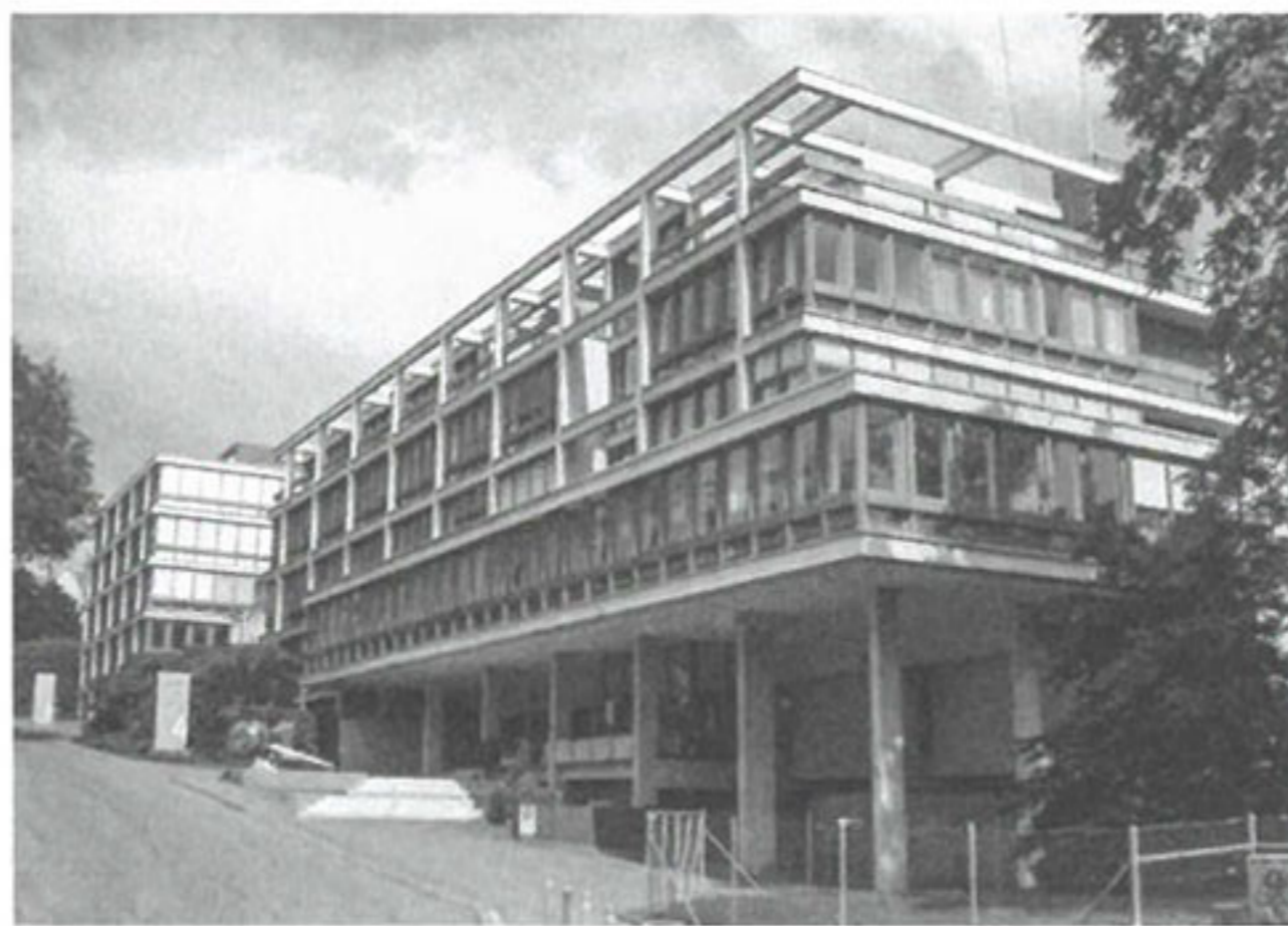
Die Strassenseite der beiden Baukörper vor dem Umbau. Sie blieb bis auf die Brüstungselemente unverändert.
