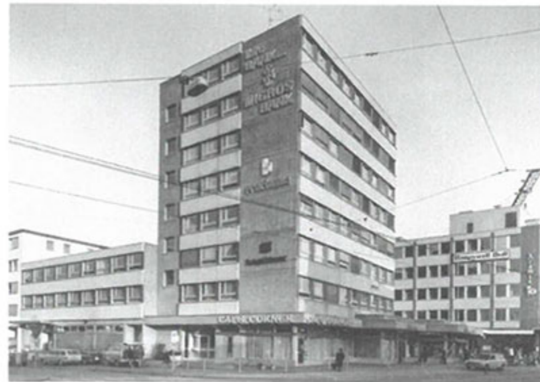
Das Bürohaus mit Bandfenstern, Betonscheiben und abgetrepptem Erdgeschoss. Foto: BAZ
