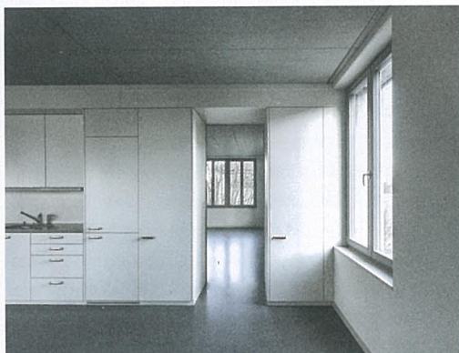
Anhydritboden, lasierte Betondecken und Prägetapeten: Grautöne dominieren auch im Inneren des Wohnhauses.
