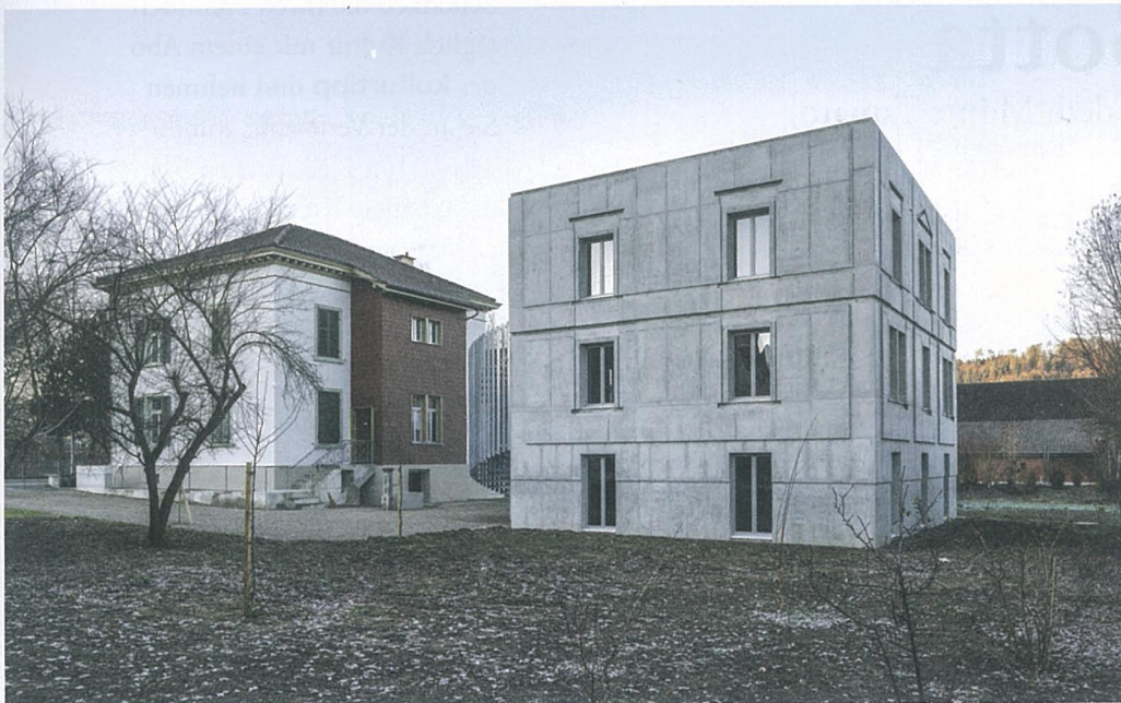
Verlorenes wiederbelebt und abstrahiert: Das Wohnhaus in Schöffland nimmt ein Schwarz-Weiss-Foto des Restaurants links vor der Entfernung des Fassadenschmucks als Vorbild für ein Relief am Betonkubus.
