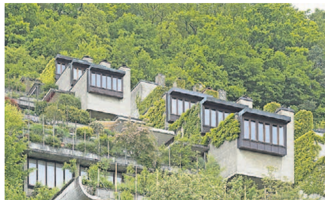
Der vorbildhafte Pionier: Terrassensiedlung Mühlehalde von Scherer, Strickler + Weber. ALEX SPICHALE
