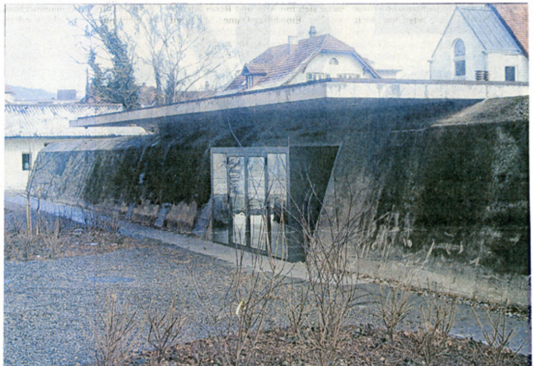
Gut gesichert Hinter dem Schutzwall aus dem Zweiten Weltkrieg werden künftig die Kleinsten unterrichtet.
